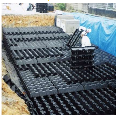
5 Lắp đặt CW
