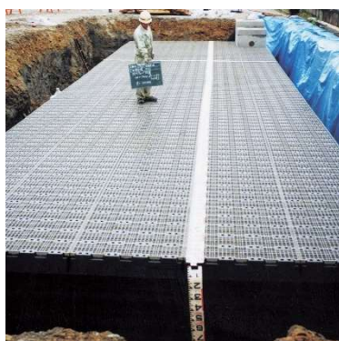
6 Lắp đặt tấm lót
