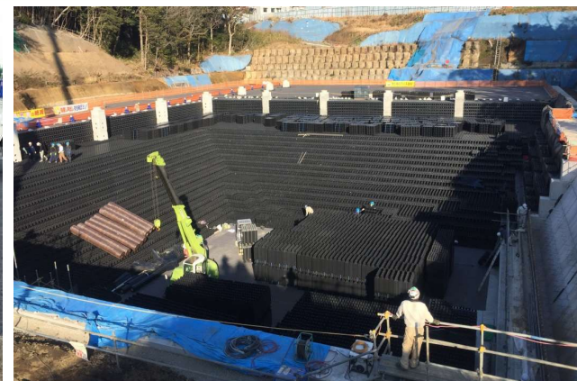
Công trình tại tỉnh Kanagawa, Nhật Bản; Dung lượng: 30,000m 3
